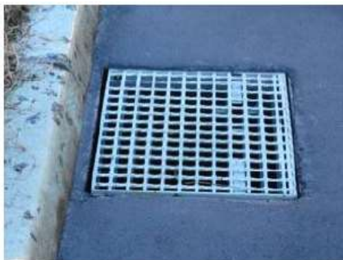
（例）グレーチング蓋の格子の形状を工夫した事例
