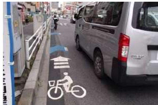
◆車道左側部の車線内に矢羽根示と自転車のピクトグラムを設置した事例
