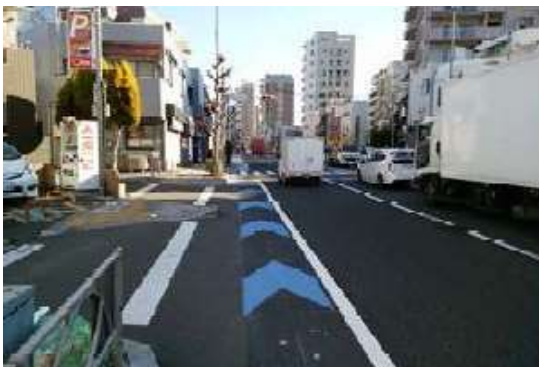
◆車道左側部の路肩内に矢羽根を設置した事例
