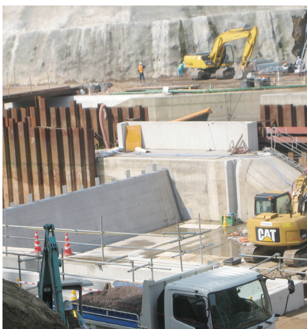
阿波井堰改築工事
