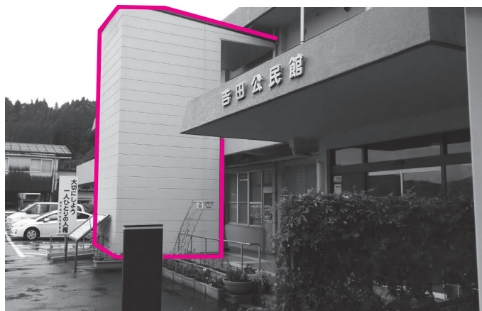
外付けエレベーター
