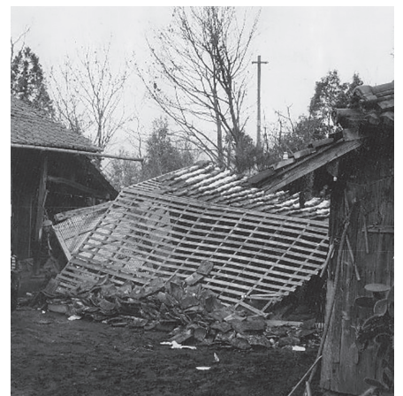
▲倒壊した家屋
