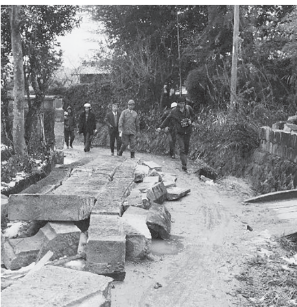
▲倒壊した石壁
