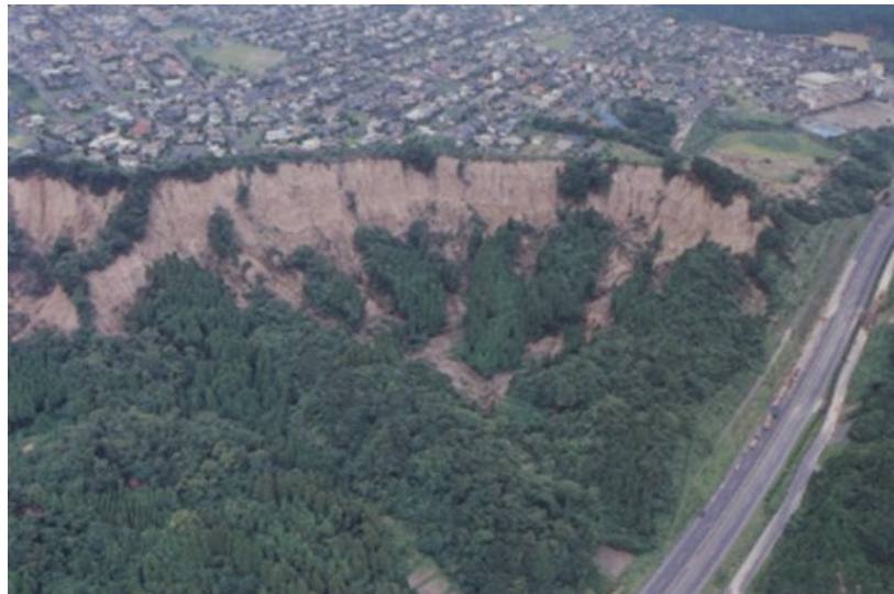
始良町（シラス崖浸食崩壊）
