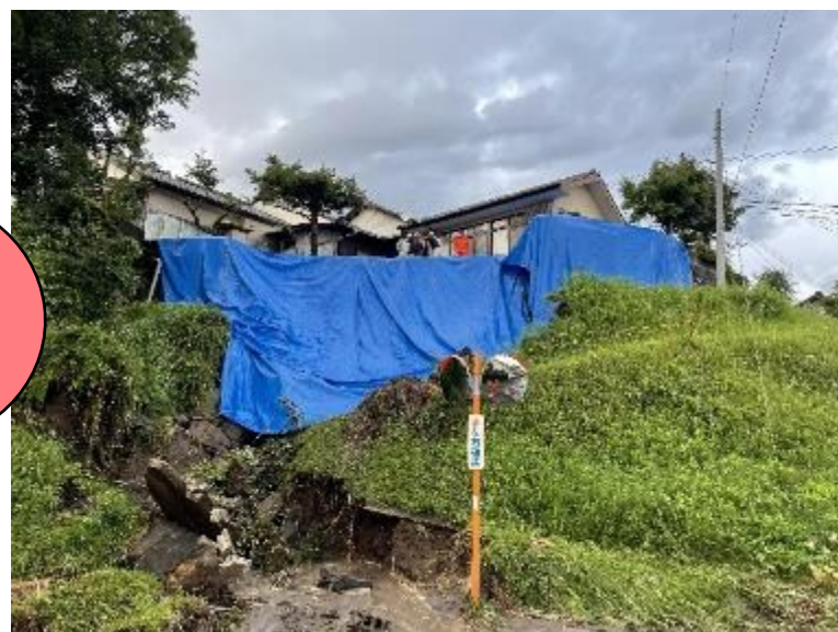
応急復旧の状況（18：30頃処置完了）
