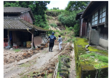
急傾斜地土砂災害 (のり面崩壊)
