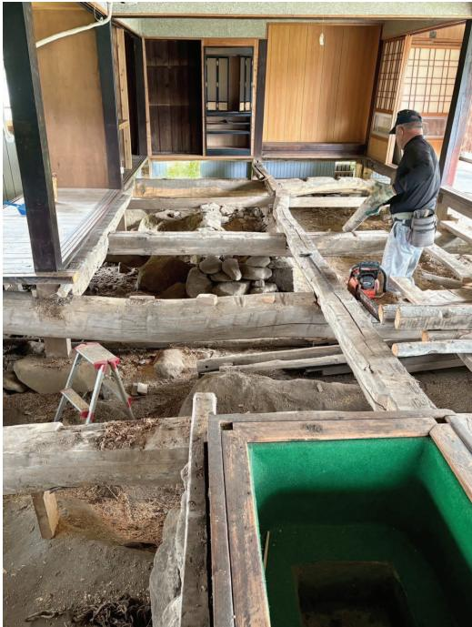
畳を撤去後床をはがし、構造材の補強、調整をおこないました。
