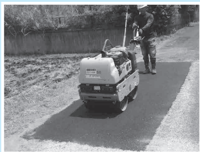
道路維持補修作業
