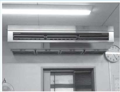
シルバーケアセンター施設整備
