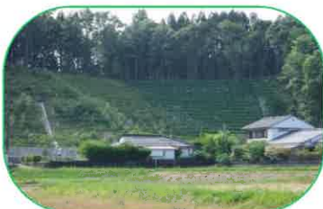
土砂崩れを防ぐ
