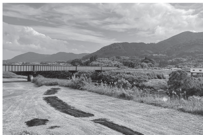
重要水防箇所である中鶴橋下流
