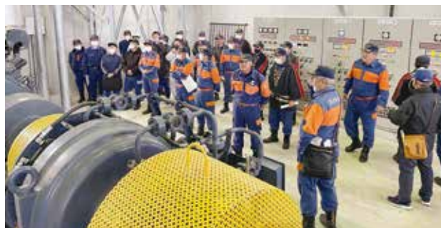
施設等研修(丸池川排水機場)
