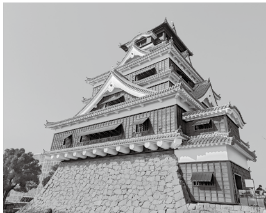
復旧された天守閣(熊本城)
