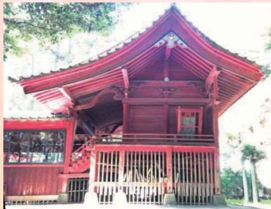
流れ造りの美しい曲線をもつ本殿
