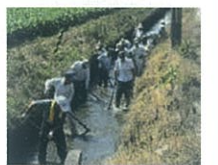
水路の泥上げ
