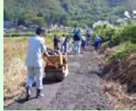
未舗装農道の舗装
