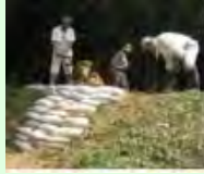
漏水箇所の補修
