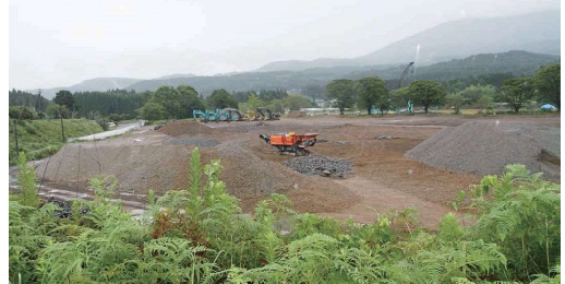
解体工事の状況
