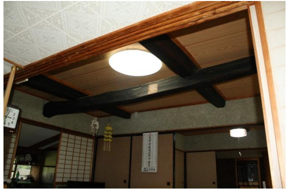
和室（天井部分）
