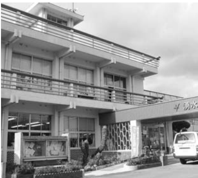
改修される両庁舎（栗野庁舎）
