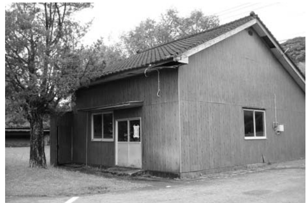
解体される弓道場
