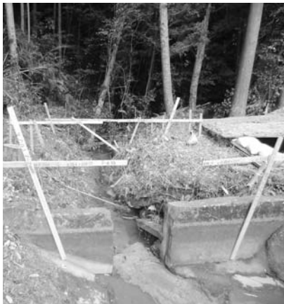
転倒ゲート（御前野地区）
