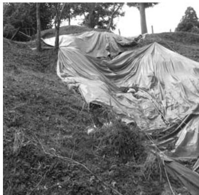
城山地内の崩壊現場
