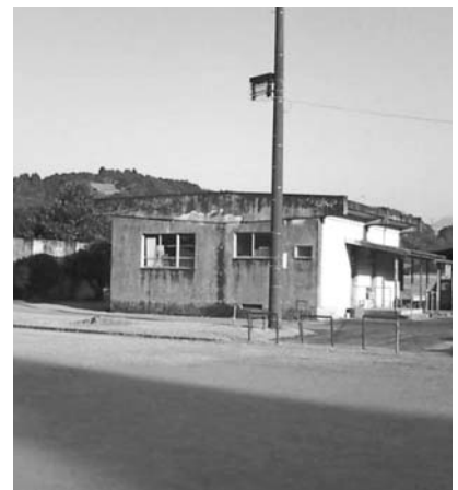
解体される旧浴場
