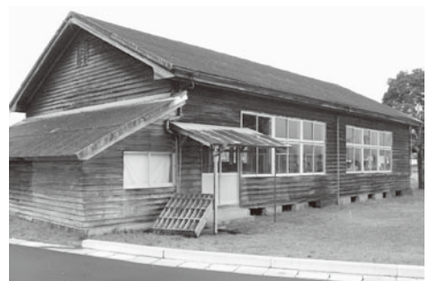
旧武道館を資料館へ改修
