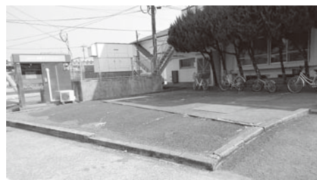
栗野庁舎浄化槽
