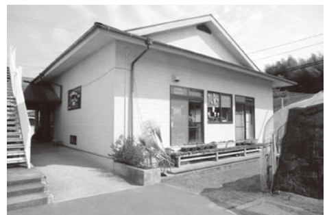
轟小学校図書室増改築
