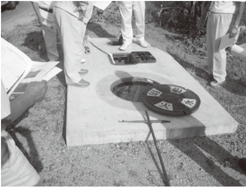
川西地内新設防火水槽
