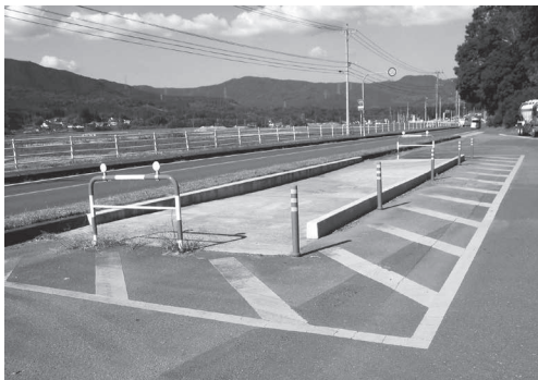
平成23年度に整備された防疫施設
