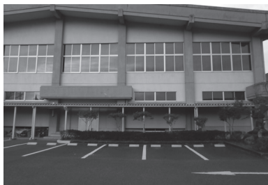
栗野小学校体育館
