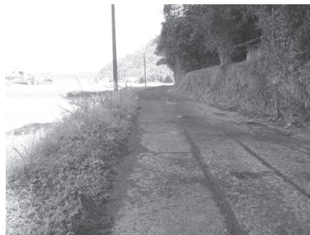
町道下中津川線の現状
