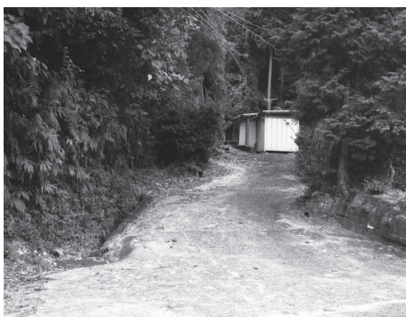
「土砂流出危険箇所」
