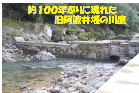
▲撤去される旧阿波井堰（上流側から撮影）
