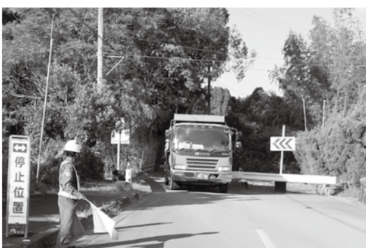
県道 102 号線狭窄部
