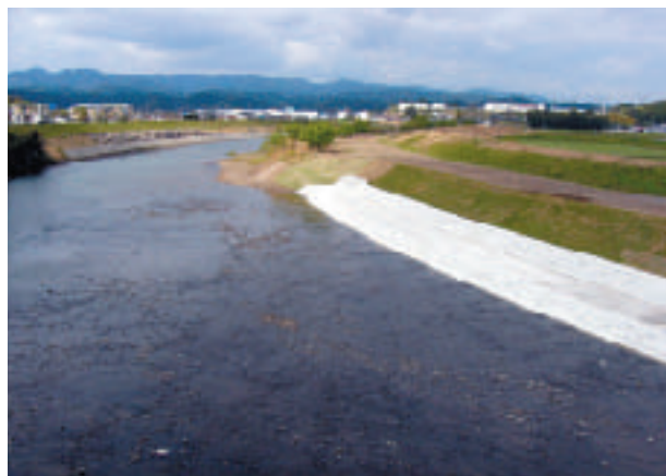
船渡橋下流右岸(完了)
