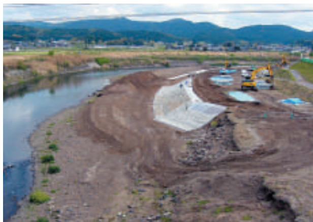
栗野橋上流左岸(施工中)
