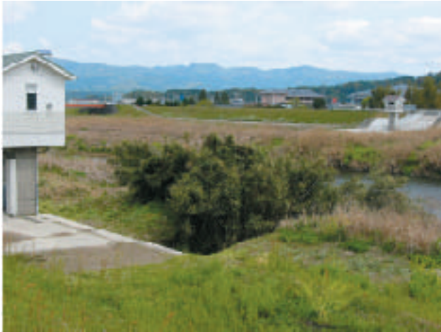
吉松排水樋管 吉松橋下流左岸(完了)
