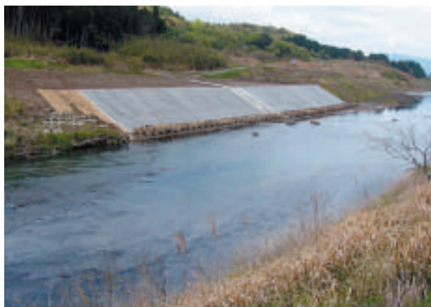
永山橋下流右岸(完了)
