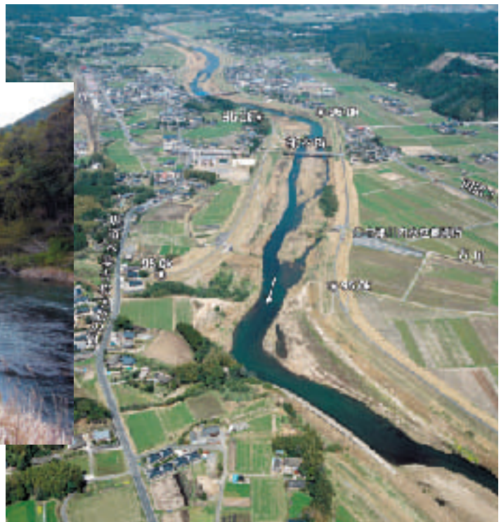
流域寄州除去(全寄州未施工)
