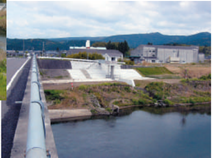
船渡橋上流右岸北方排水樋管(完了)
