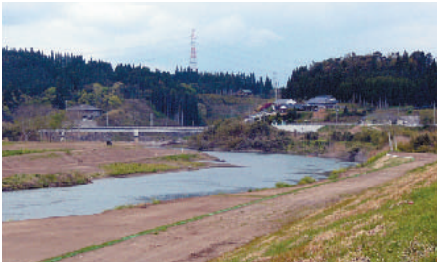
轟橋上流寄州除去 (完了)
