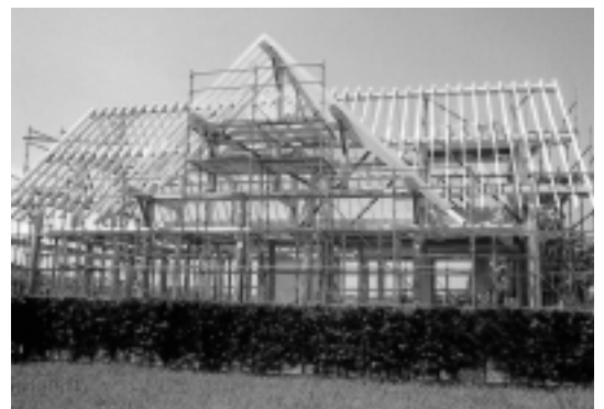
県産材利用住宅
