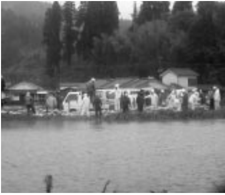
越水の危機にさらされた桶寄川堤防（左岸）
