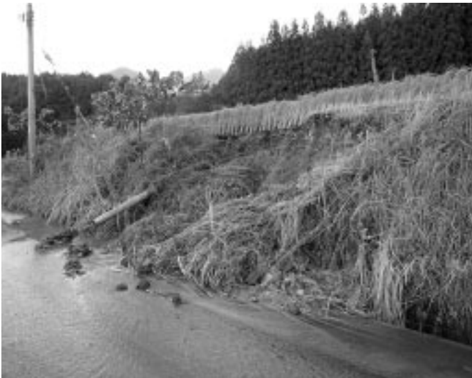
西海寺線（永山地区）
