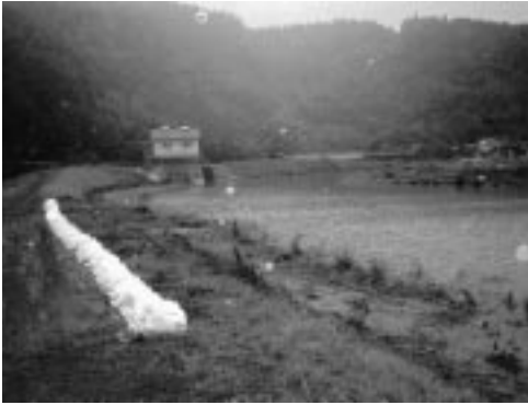
越水防止のため土のうが積まれた桶寄川堤防
