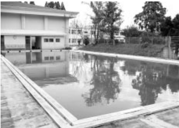
轟小学校のプール
