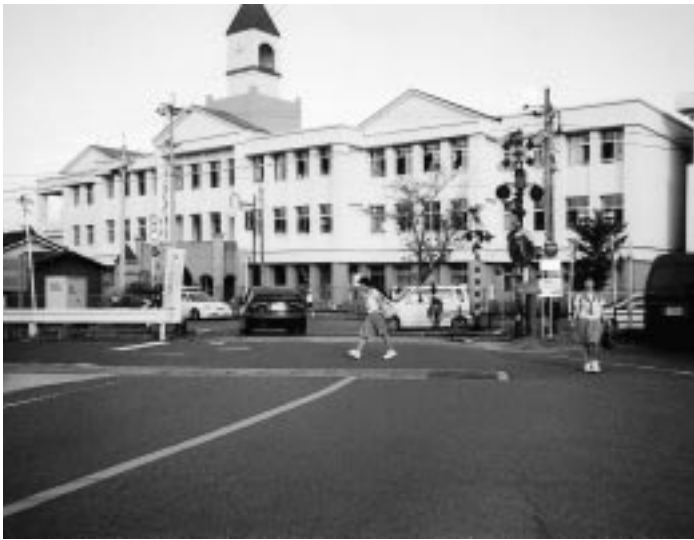
拡幅が望まれる長谷踏切及び周辺道路（栗野小前）
