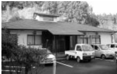
米永地区集会施設
