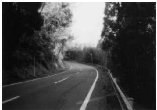
約1km区間人家のない通学道路(町道清滝線・中津川地区)
