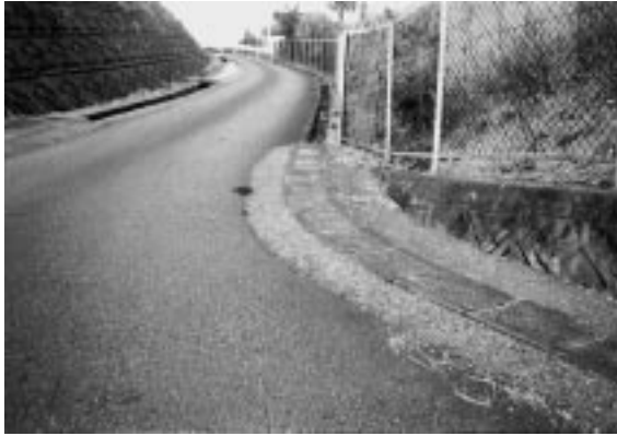
全面蓋板設置を望む牛瀬戸共同墓地侵入道路
