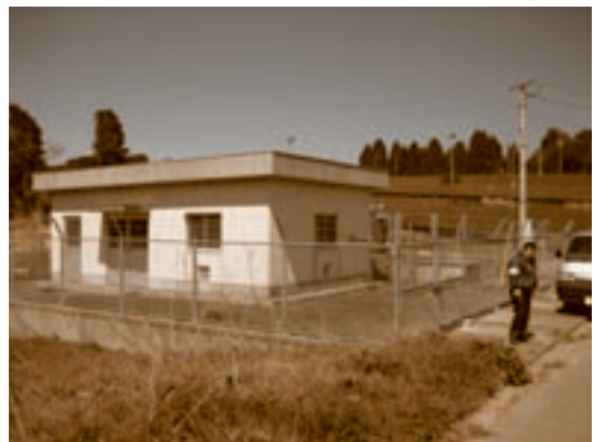
魚野地区給水施設
