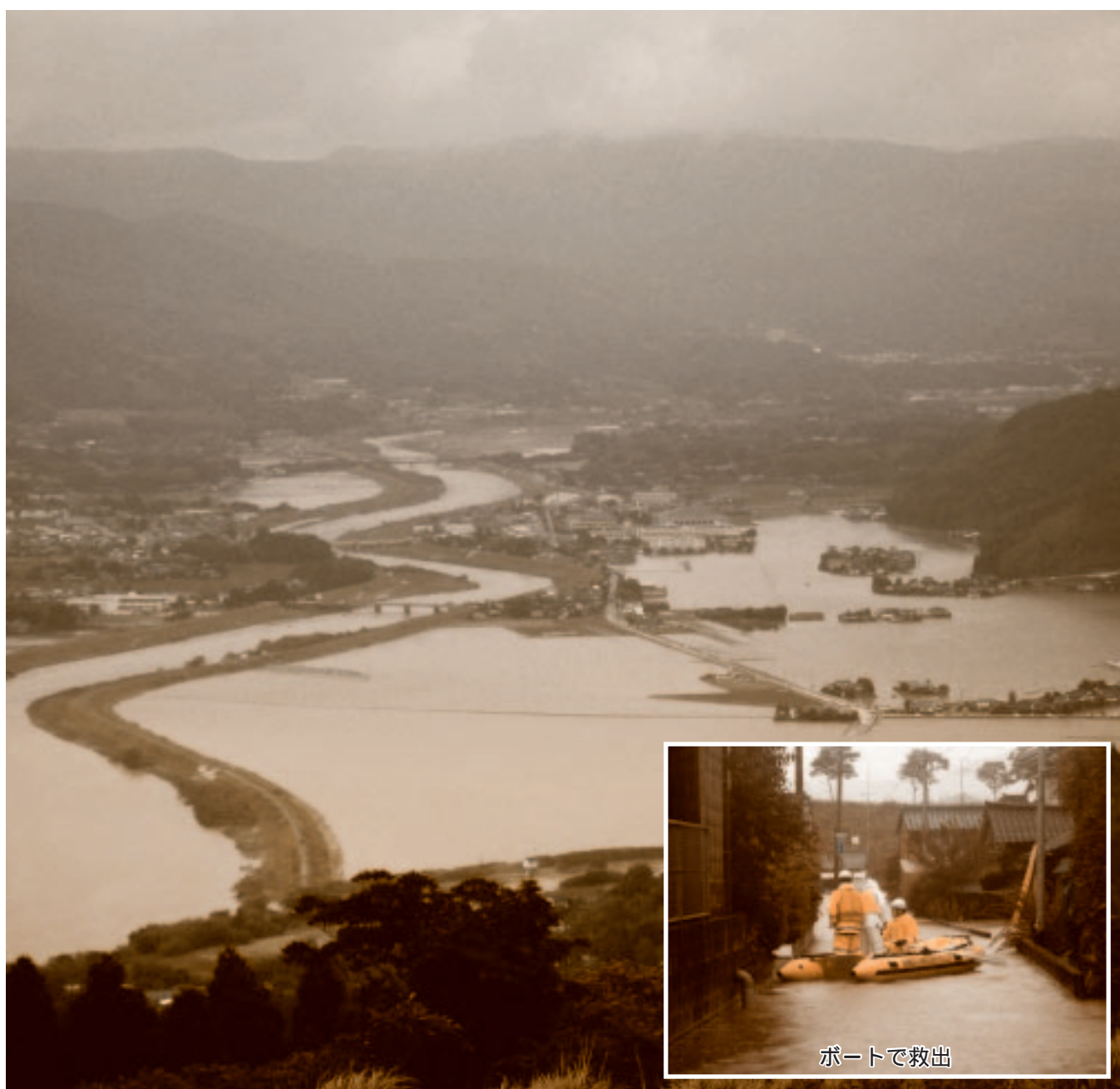
木原展望台より見た吉松地区の災害状況
