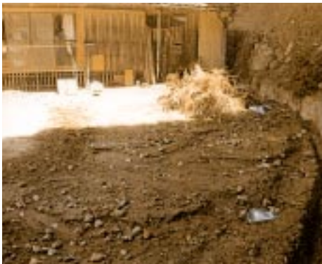
宅地に流れ込んだ土砂
