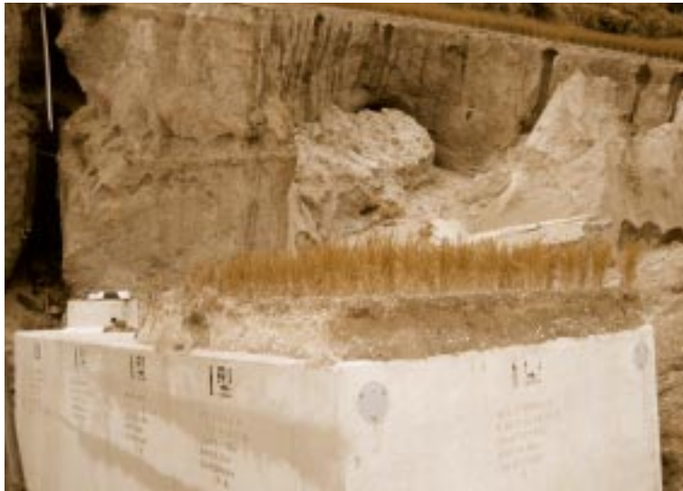
田の下に埋設してあった防火水槽・轟地区 (かしたなし) (頭無)
