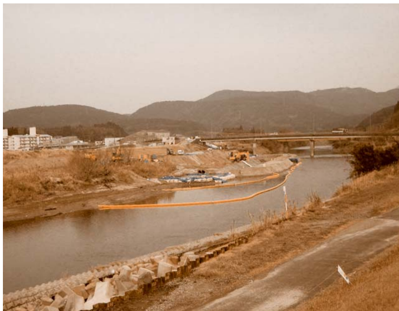
船渡橋下流の河川改修
