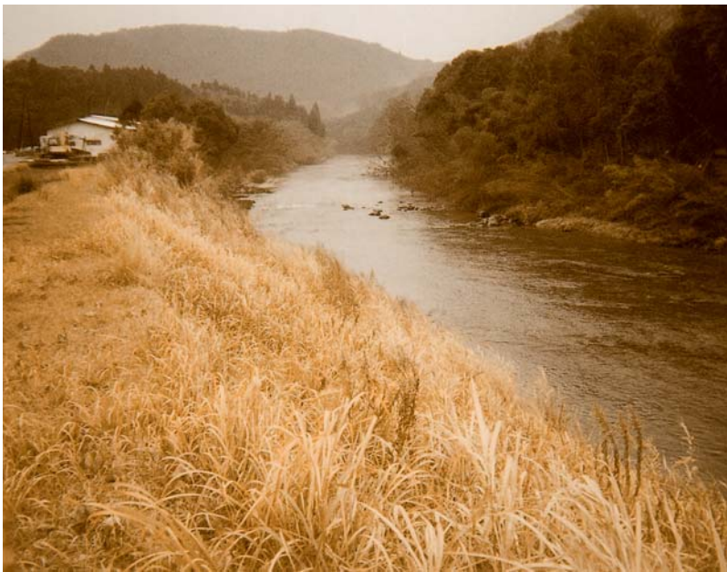
川添狭窄部の拡幅が急務とされる井堰上流
