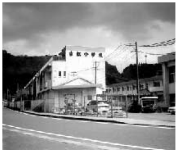
建替予定の吉松小学校校舎
