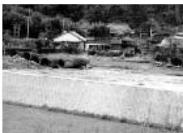
工事中の排水機場（門前地区）
