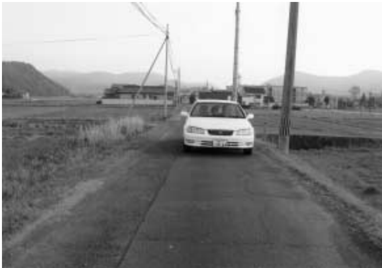
離合が困難な基幹町道（麓地区）
