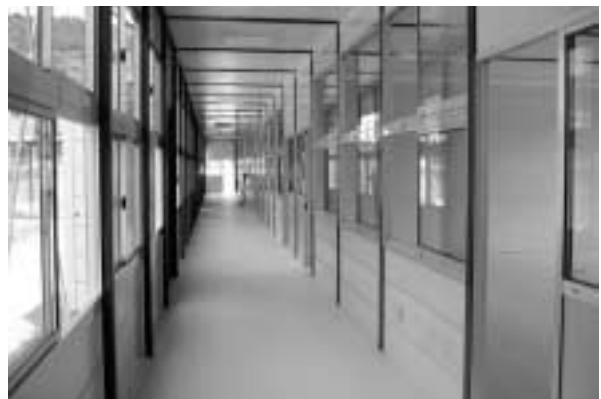
仮設校舎内廊下
