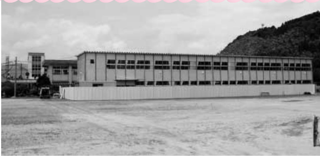
整備中の吉松小学校仮設校舎
