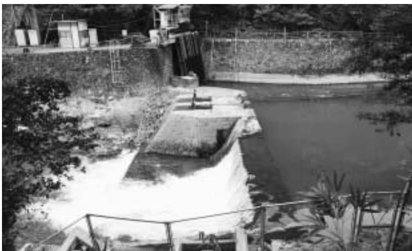
早期改修が望まれる阿波井堰
