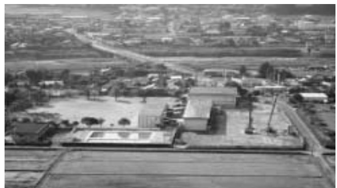
改築工事に着手した吉松小学校
