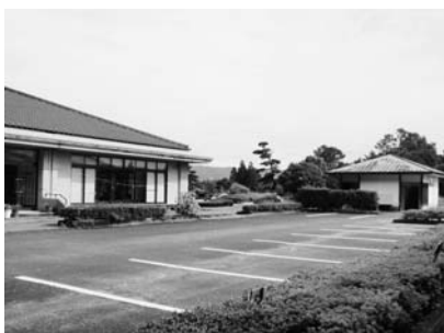
改修されるシルバーケアセンター
