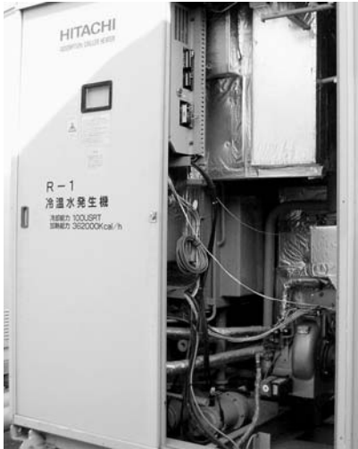
修繕される総合交流施設空調ボイラー
